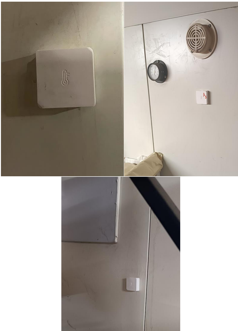
Εικόνα 2.1 Επάνω αριστερά και δεξιά: Εγκατάσταση αισθητήρων θερμοκρασίας και υγρασίας στις αποθήκες Κάτω κέντρο: Εγκατάσταση αισθητήρων θερμοκρασίας και υγρασίας στο κατάστημα της Μασούτης ΑΕ .
